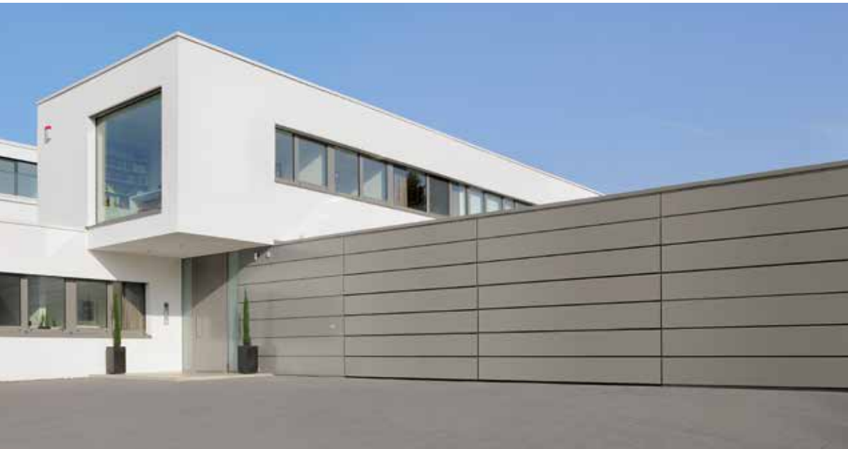
Bauseitige Beplankung mit Aluminium-Verbundplatten
