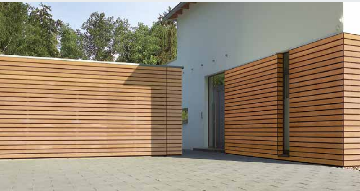
Bauseitige Beplankung mit Holzpaneelen
